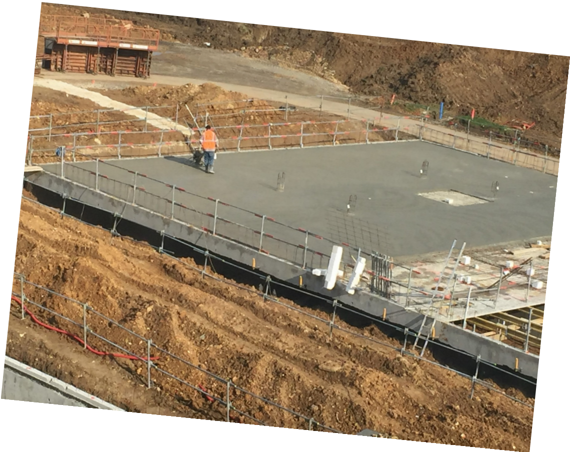
Coule de la chape bâtiment SSR
