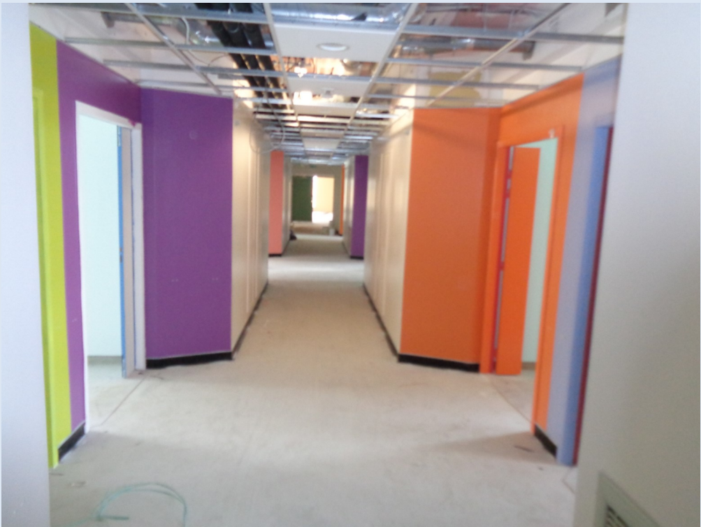
Mise en peinture nouveau bâtiment USLD
