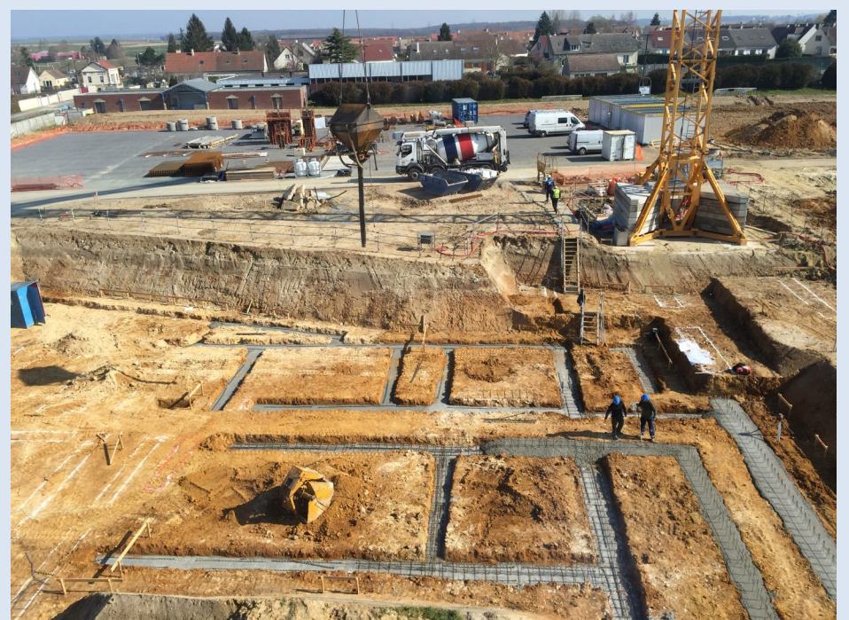
Coule des fondations des bâtiments SSR et USLD
