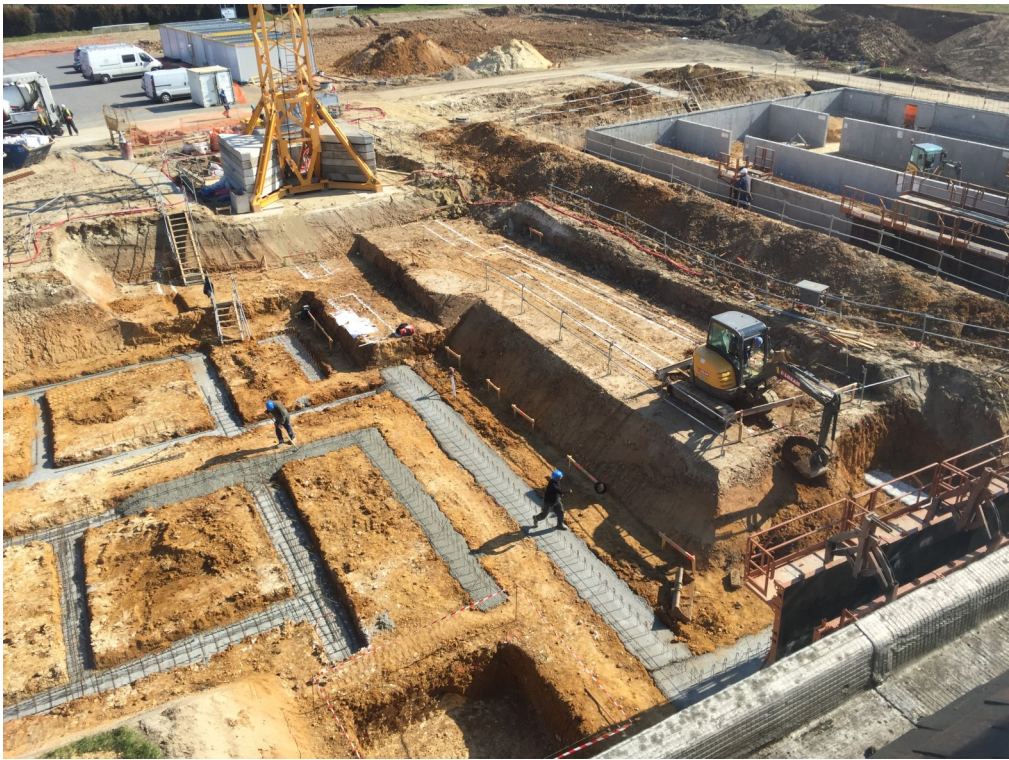
Travaux de fondations niveau -1 bâtiment SSR/USLD
