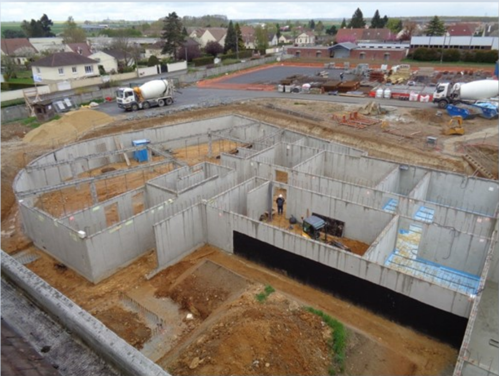
Montage cloison bâtiment nouvel espace des consultations de médecine générale
