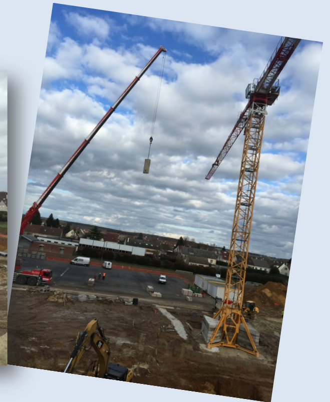
Janvier 2016 : arrivée des camions et grues sur le site de l'ancien stade de football
