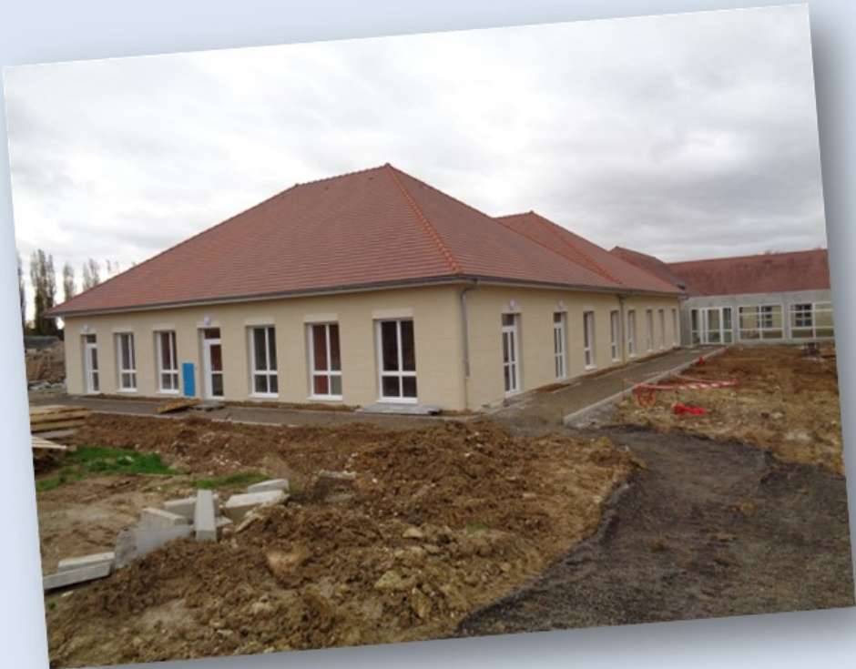
Novembre 2016 : réception architecturale et technique, levée des réserves du bâtiment SSR.
