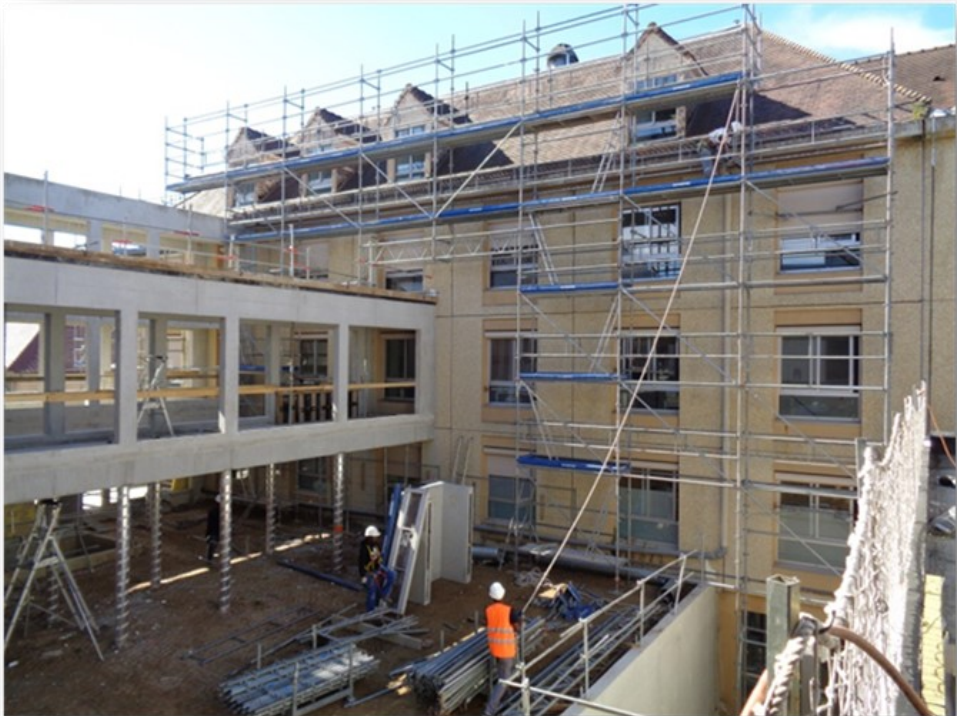
Couloir reliant l'ancien bâtiment à l' extension USLD
