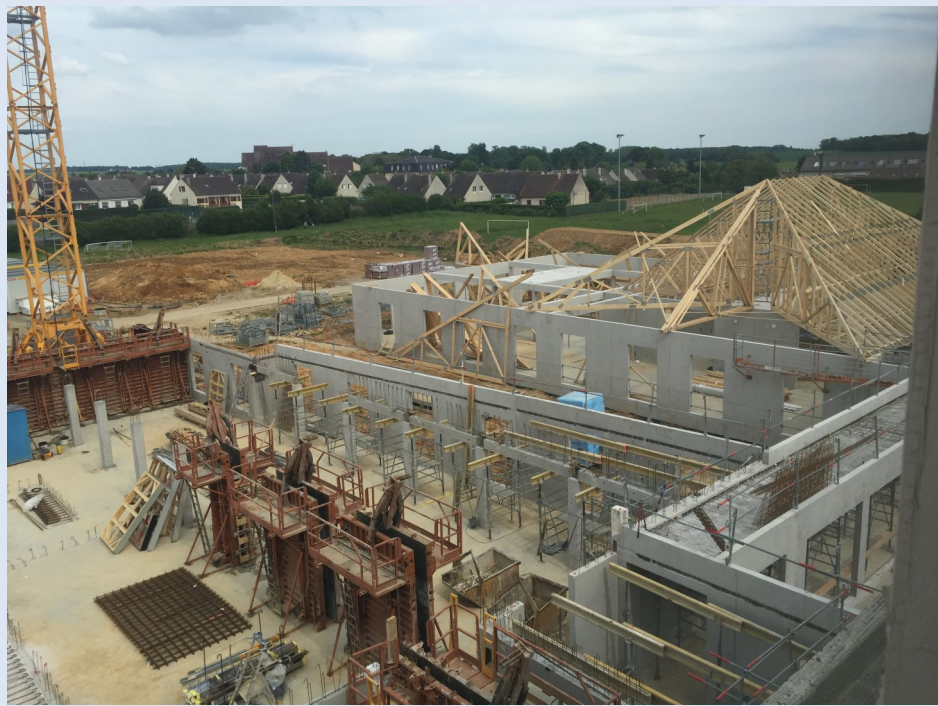
Montage des cloisons et charpente du bâtiment SSR
