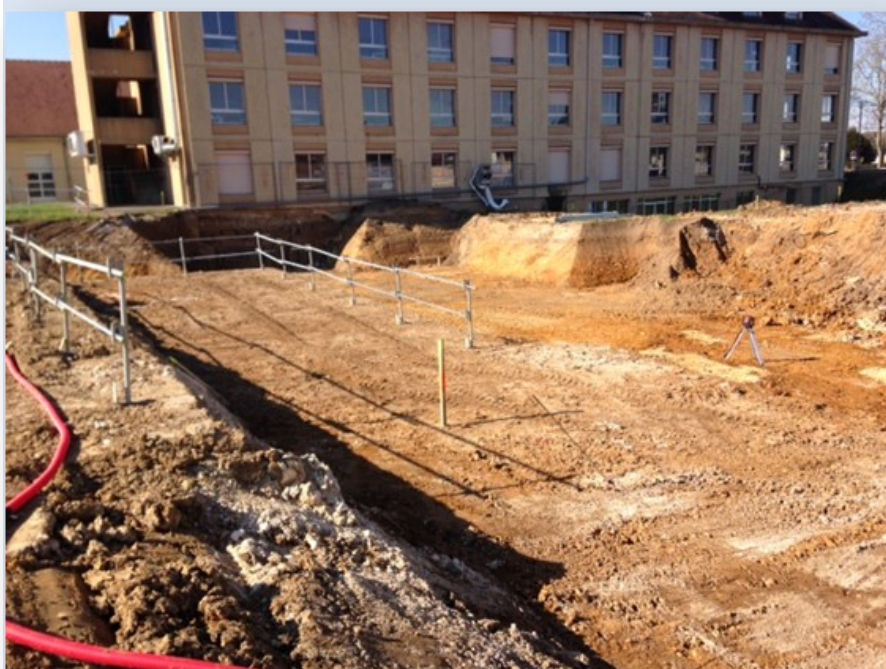
Février 2016 : Terrassement des bâtiments SSR et USLD
