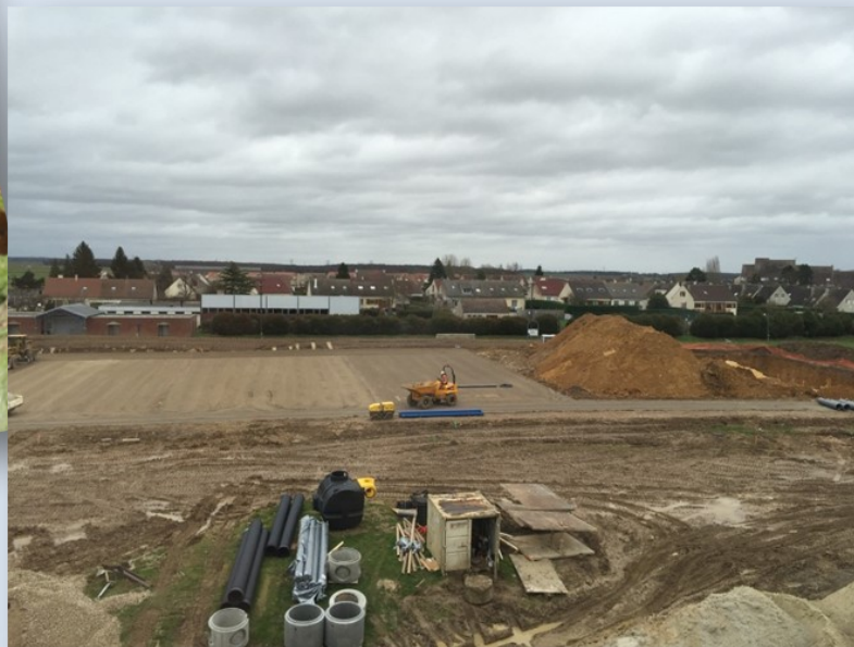
14 décembre 2015 : démarrage des travaux.
