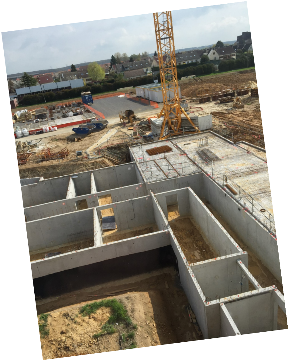
Cloisons niveau -1 bâtiment SSR/USLD
