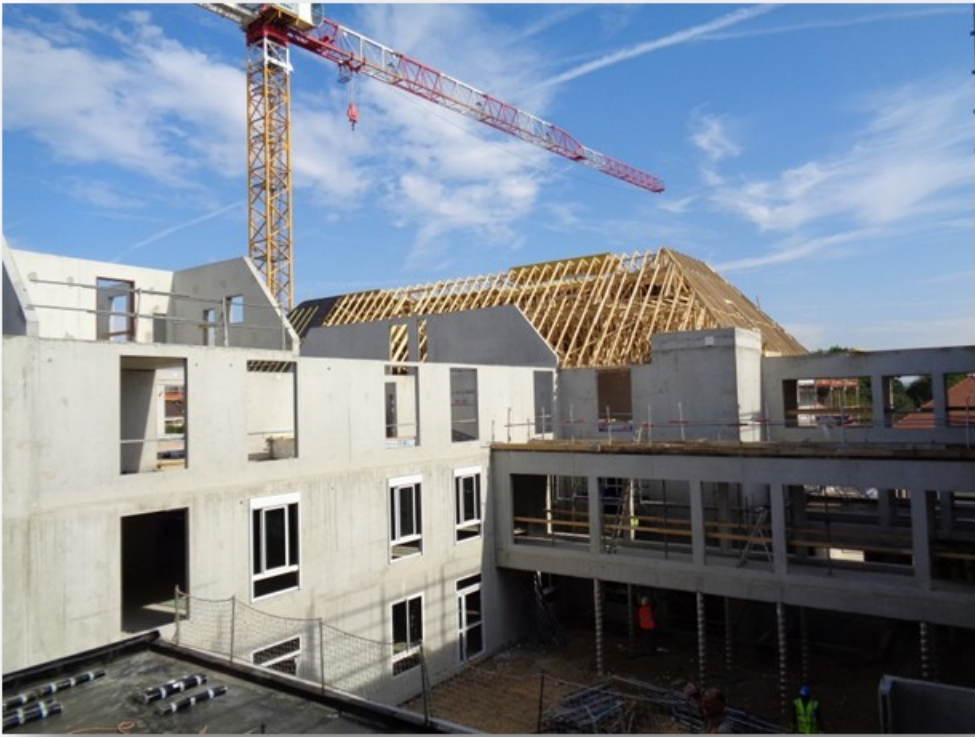
Extension USLD et couloir reliant le bâtiment Jean-Bernard MAUVAIS
